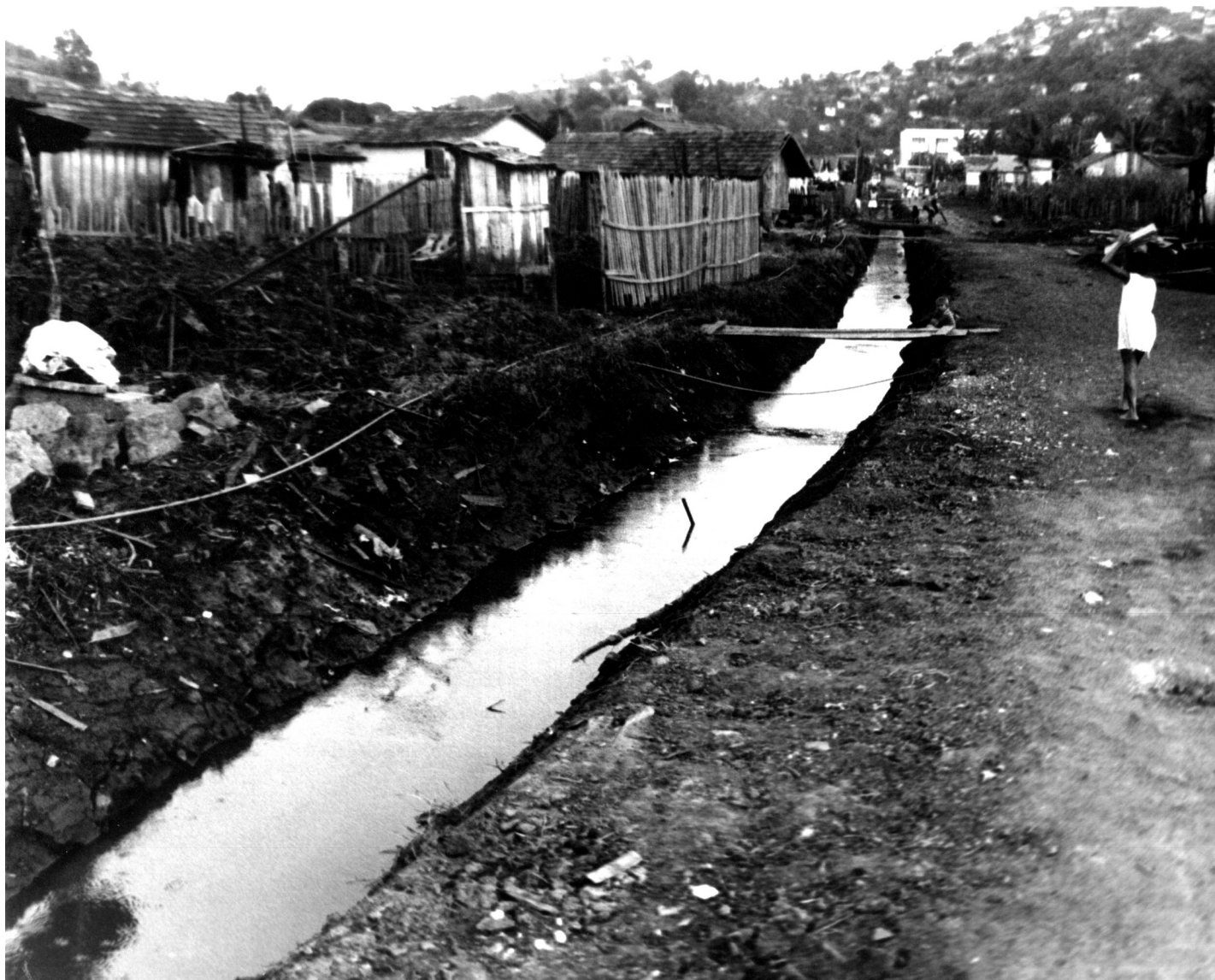
Canal de lançamento de águas de esgoto, na Rua Daniel Abreu Machado (data indefinida) Imagem cedida pelo arquivo público municipal de Vitória
