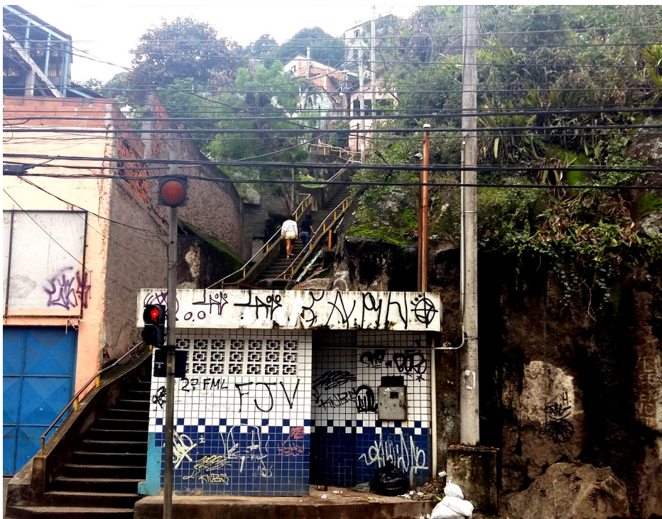
Elevatória de Jaburu, localizada na Avenida Vitória – Vitória/ES
